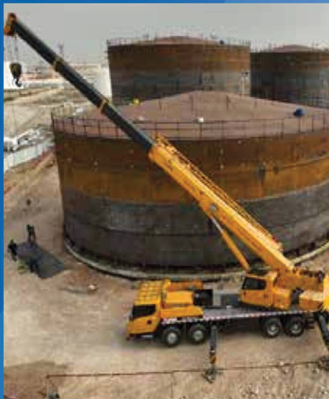
75 TON SIX WHEEL CRANE
